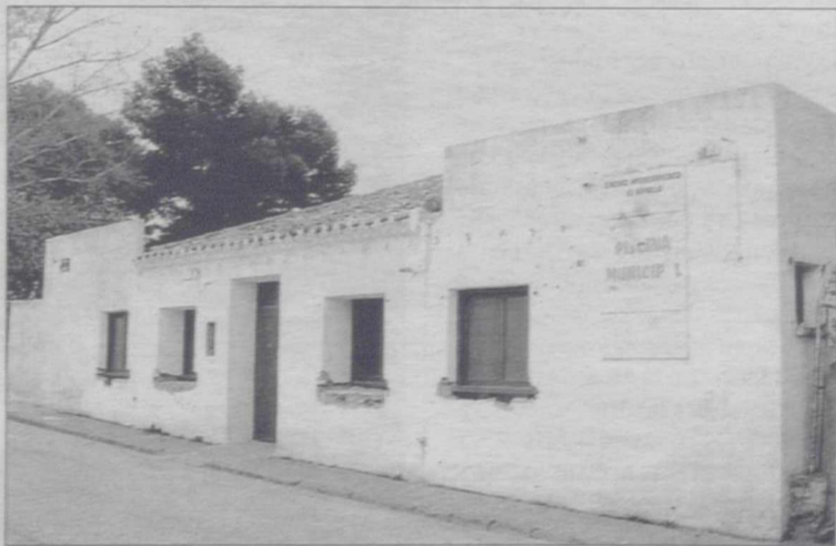
Imagen de la infraestructura que alberga la piscina municipal. / AYUNTAMIENTO
