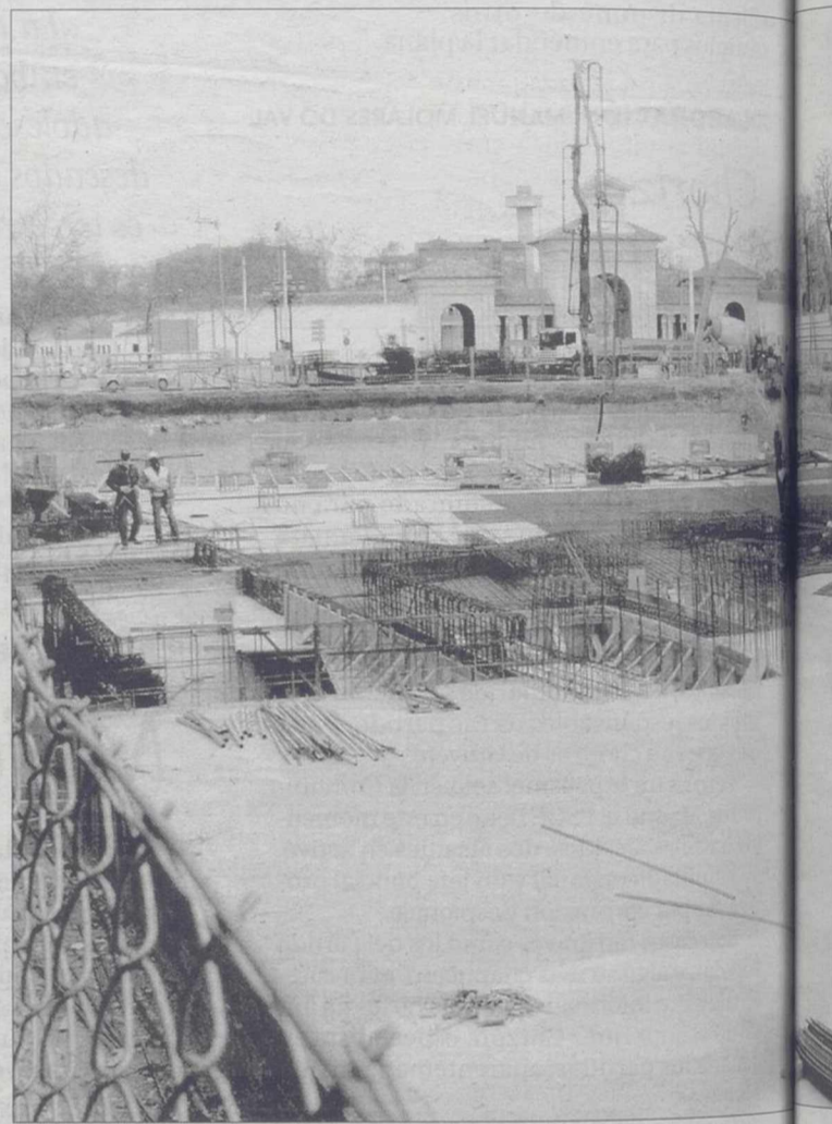
Aspecto actual de las obras del aparcamiento subterráneo. / ARTURO PÉREZ
