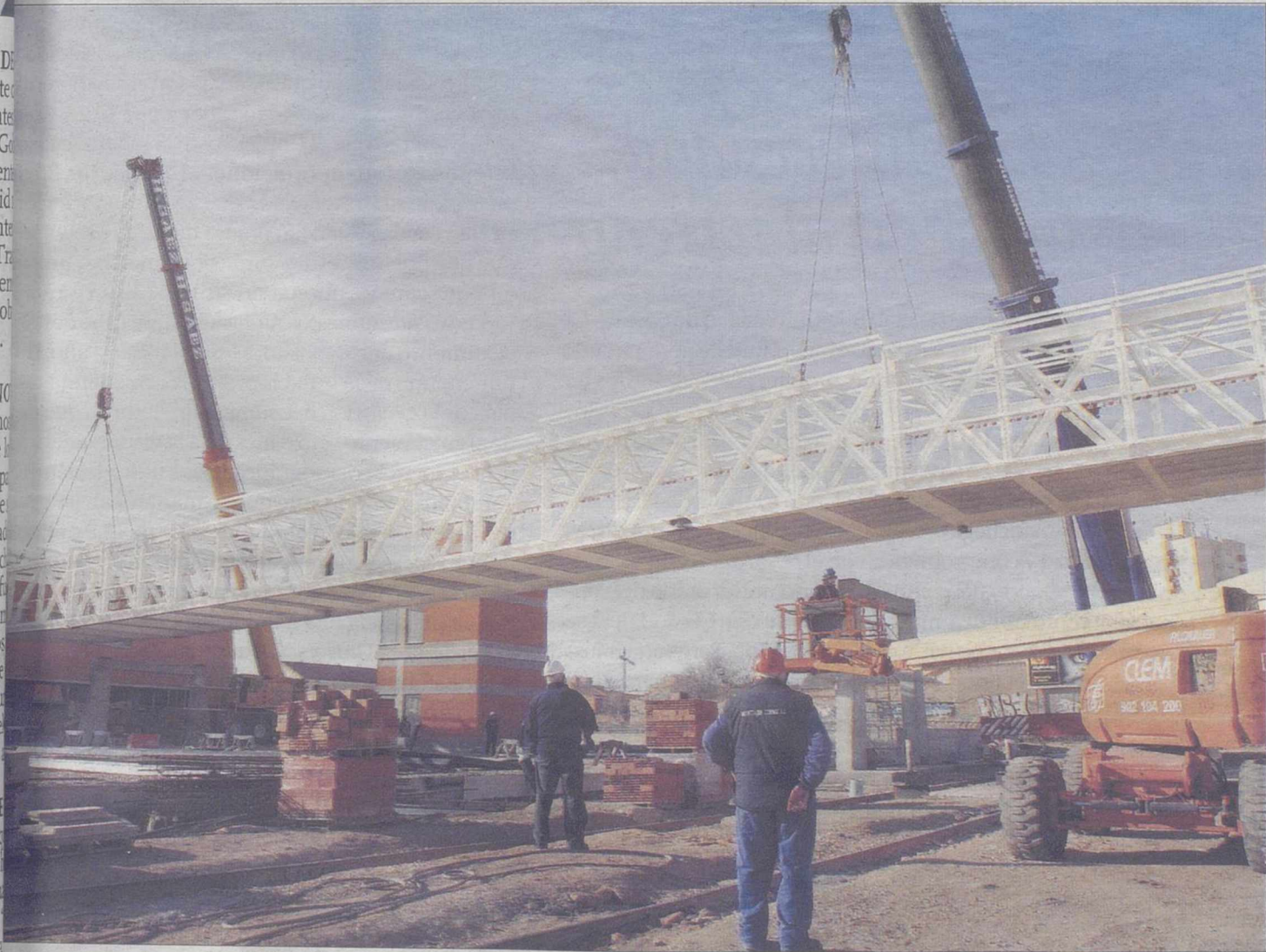
Se levantó la primera parte de la estructura de la pasarela, de alrededor de 90.000 kilos de hierro, estando previsto que la semana próxima llegue el resto./C. LÓPEZ
