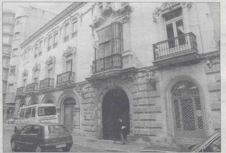
El edificio de Cruz Roja se encuentra situado en la calle San Antonio, 19. / C. LÓPEZ
