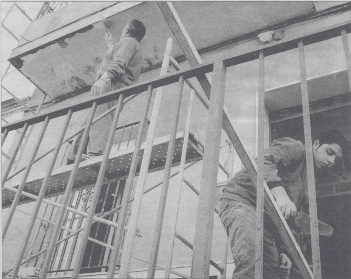
Unos operarios, realizando unas obras en un edificio
