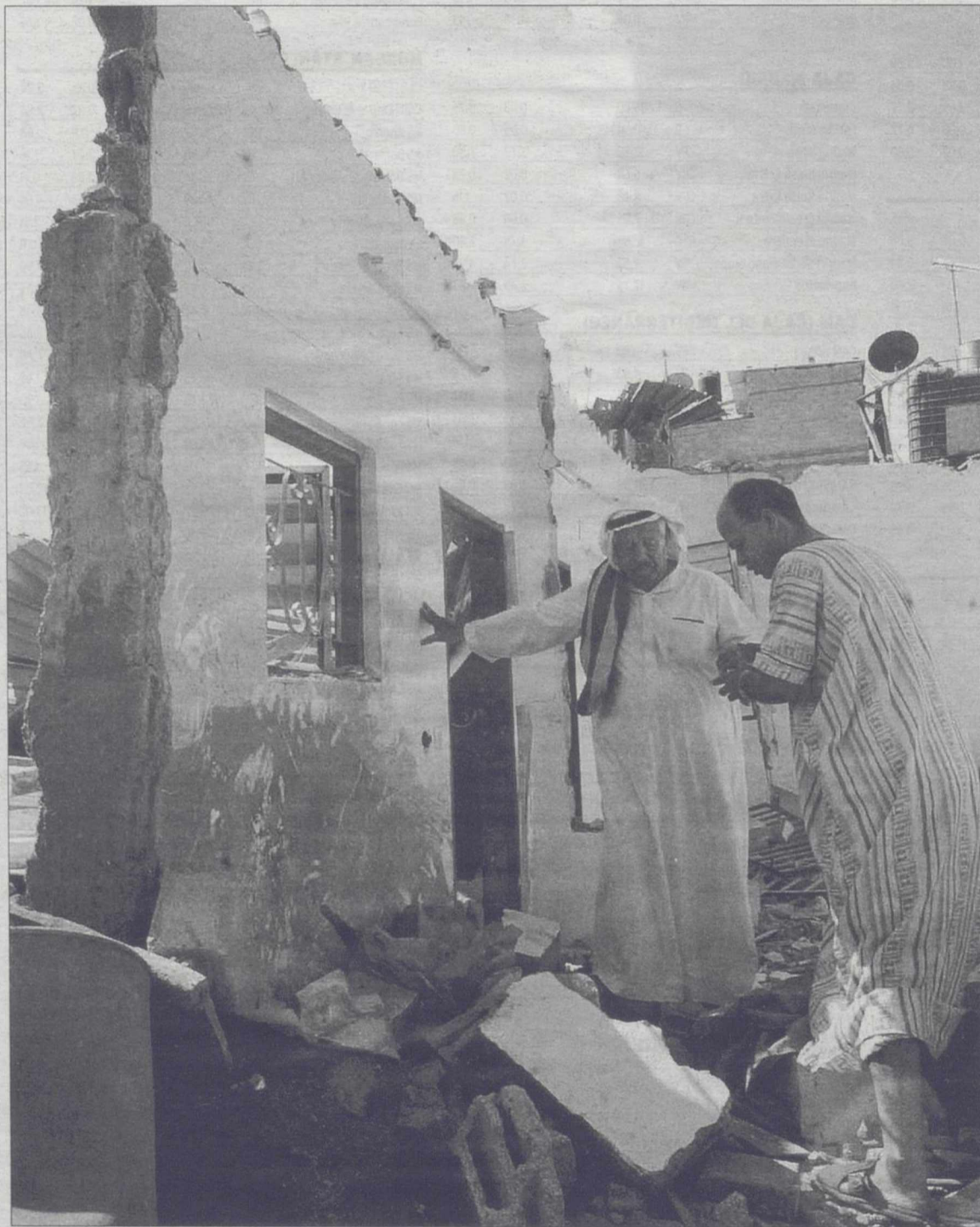
Dos palestinos observan los daños causados por tropas hebreas en una vivienda del campo de Yebalia. / M. SABER (EPA)
