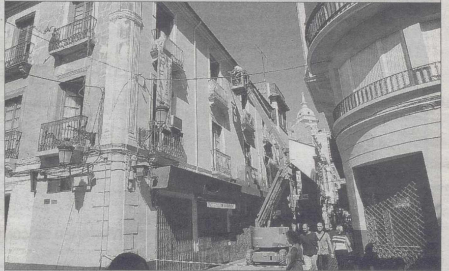
Lavando la cara del viejo Albacete. Un característico edificio de la céntrica calle Concepción está recuperando su primitivo aspecto tras los trabajos de rehabilitación que se vienen realizando durante los últimos días. /ARTURO PÉREZ
