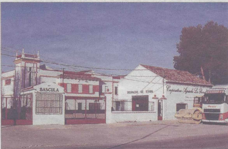
Instalaciones de la Cooperativa «La Remediadora» de La Roda./LAMORA
