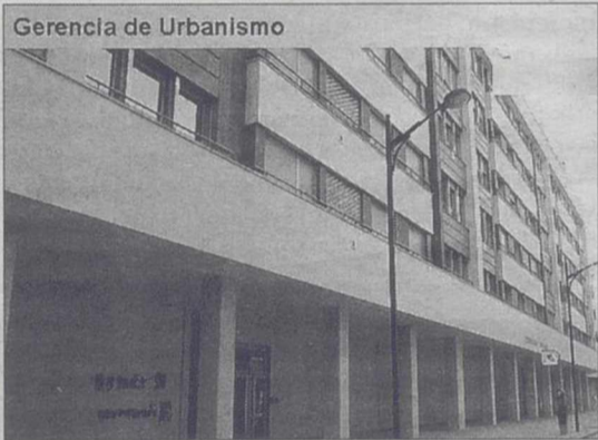
En el local se instalará la Gerencia de Urbanismo.
