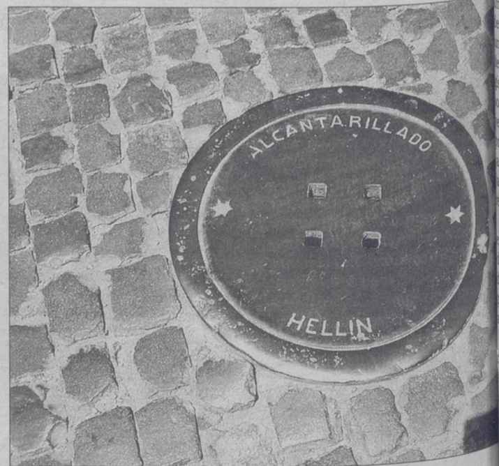
El alcantarillado, asignatura pendiente desde hace años. (A. ROMERO)
