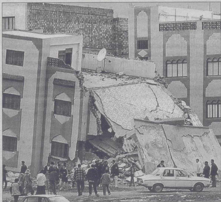
Vecinos de Imzuren, junto a uno de los edificios derrumbado. / K.S. (EFE)
