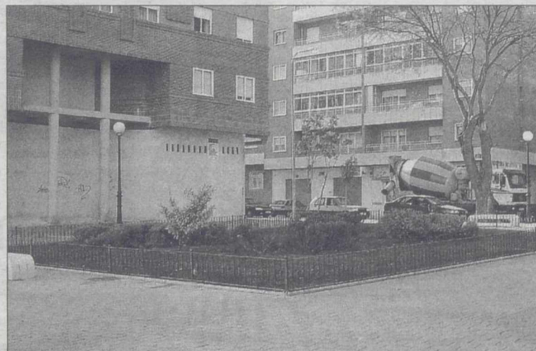
Las obras han durado ocho meses.
