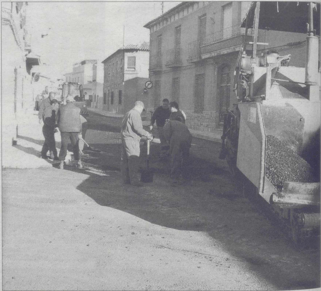
Está previsto que para el Carnaval el primer tramo del proyecto esté finalizado. / TERESA JIMÉNEZ
