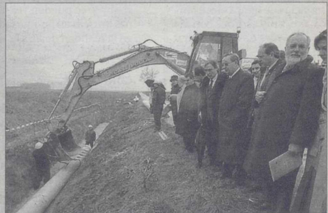
Arias Cañete, durante el inicio de las obras del canal. / R. CACHO (ICAL)
