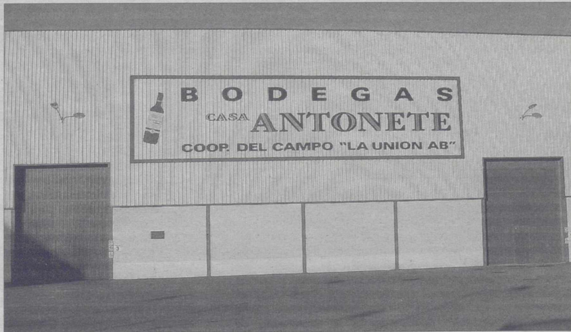
Naves isotermas con instalación de frío, dentro de las cuales están los nuevos depósitos de vino./C.M. BARREDA
