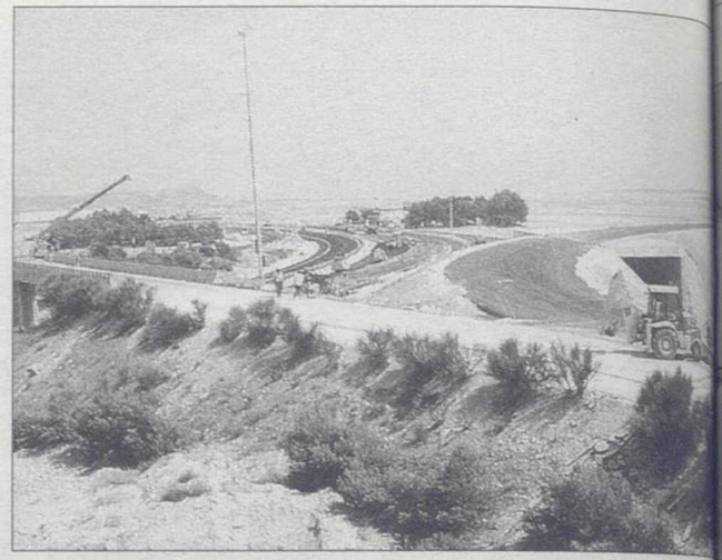
Autovía en construcción. / LA TRIBUNA
