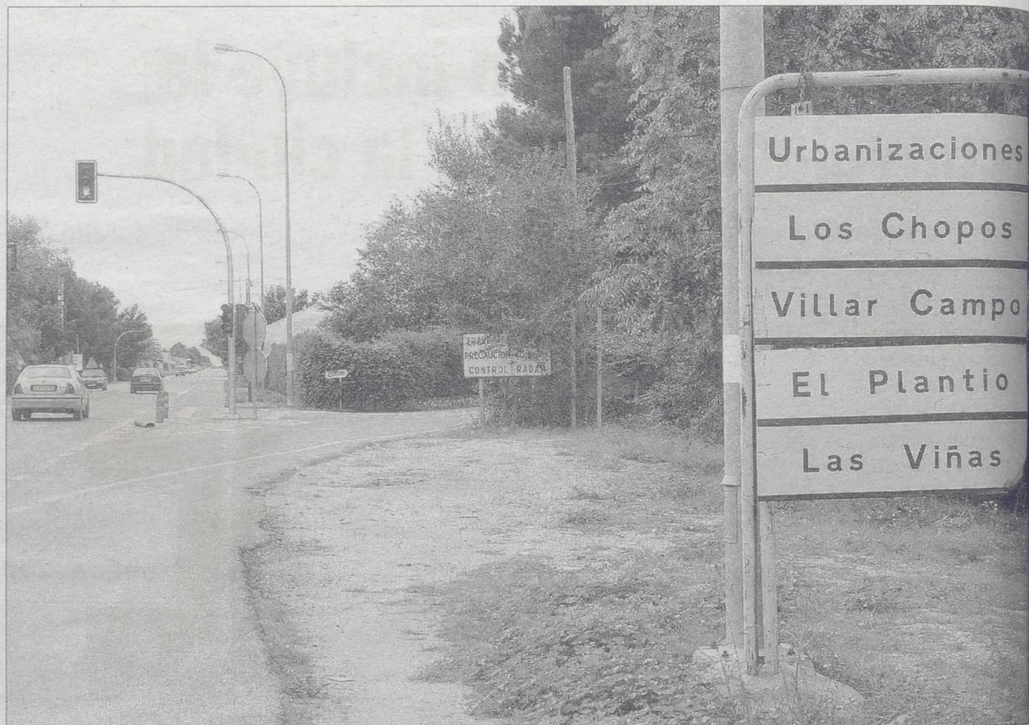
Numerosas urbanizaciones ilegales se beneficiarán de las obras de canalización que se acometerán en «El Plantío». / LA TRIBUNA
