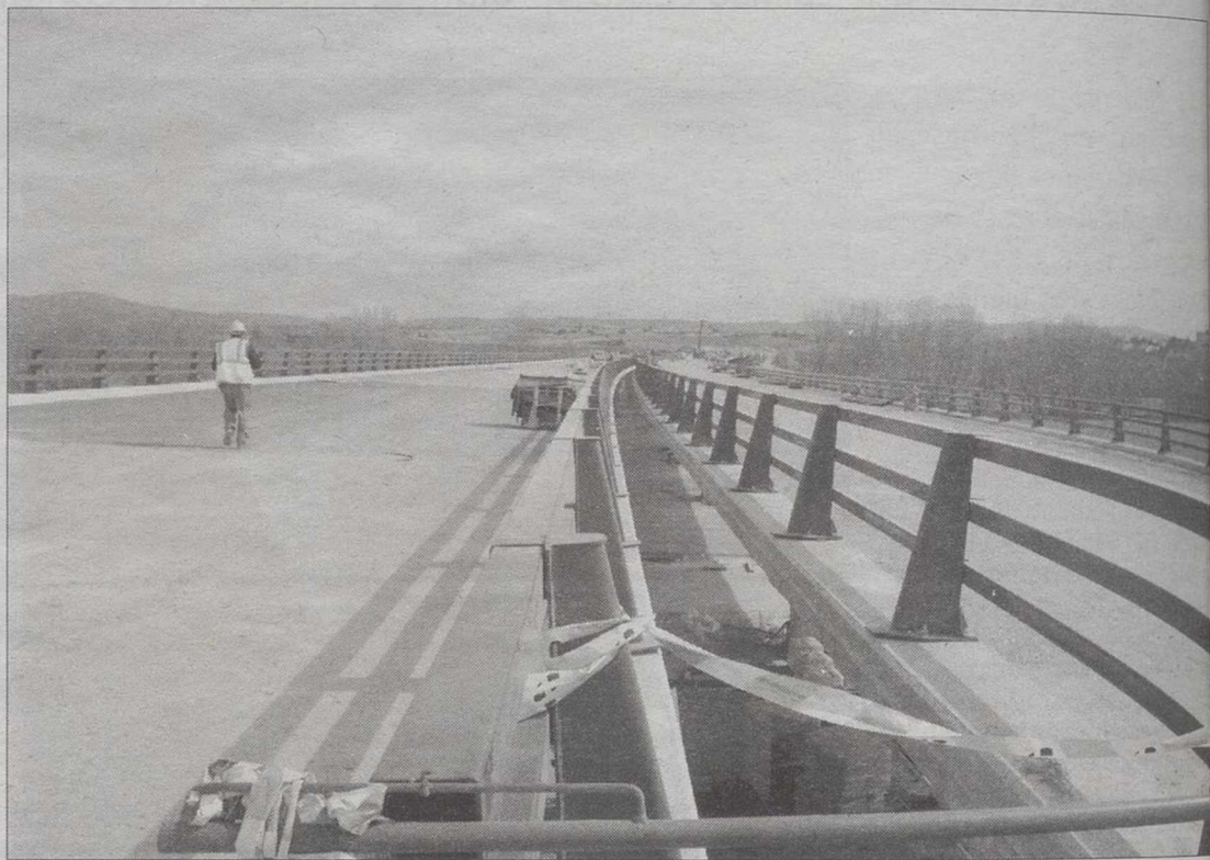
La Autovía de Castilla-La Mancha cuenta con 71,37 kilómetros en marcha. / FOTO RES
