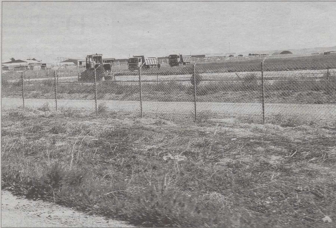
Las obras de la terminal provisional se iniciaron hace unas semanas. / ARTURO PEREZ
