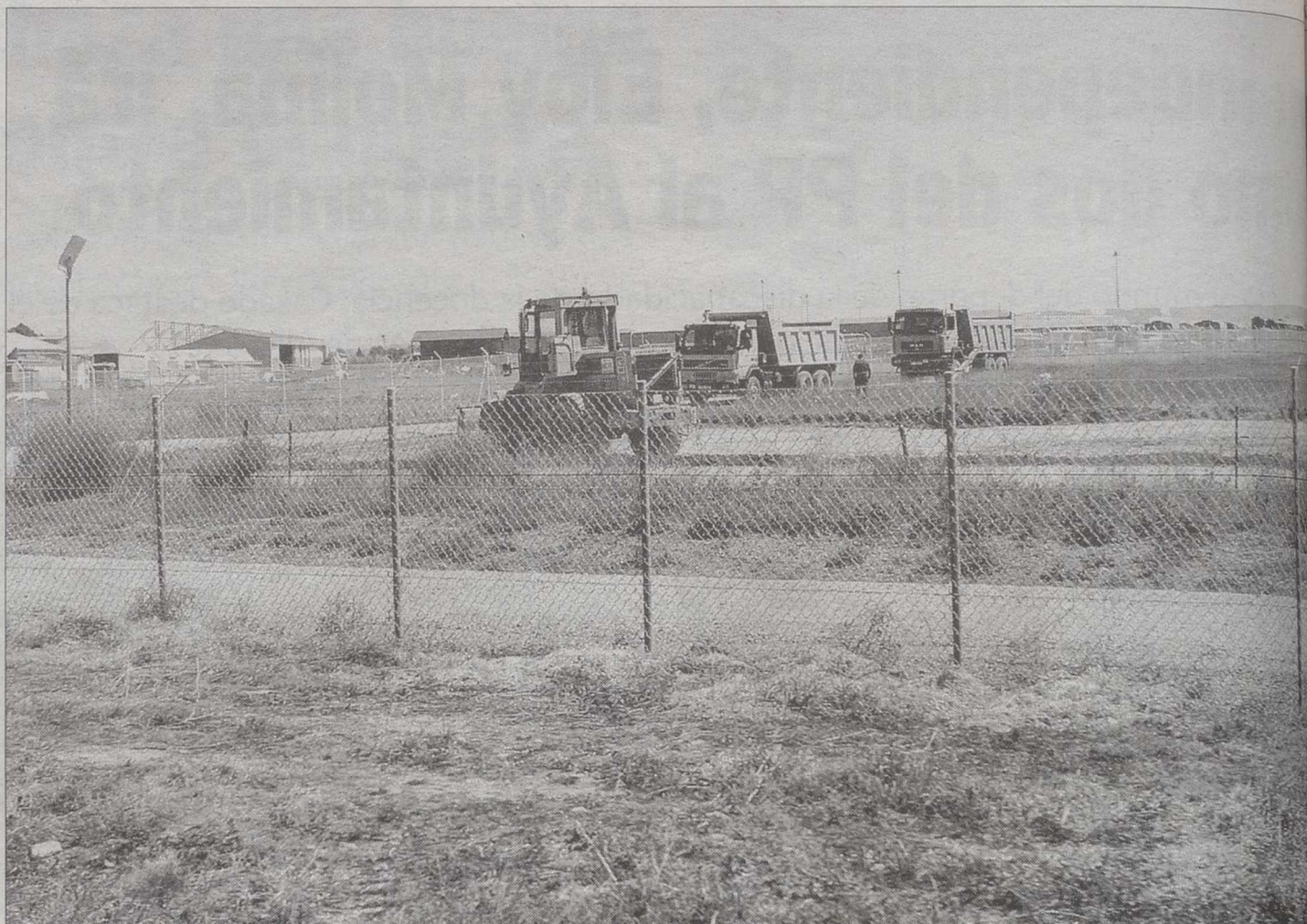
El jueves se iniciaron las obras de la terminal provisional del aeropuerto civil de Albacete./ARTURO PEREZ
