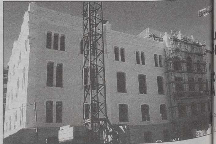
Ayer se estaban instalando los cristales.
