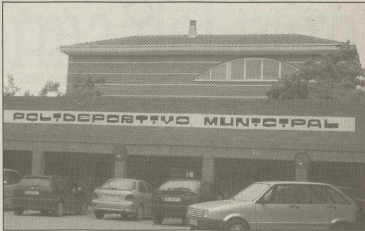
Polideportivo del barrio de 'Los Pintores'.
