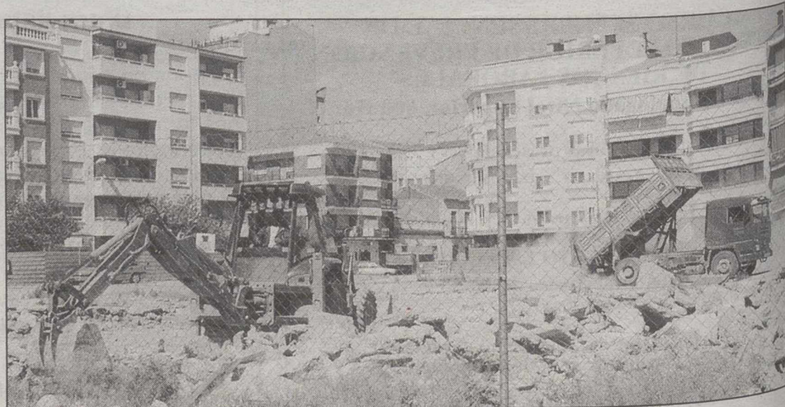
El alcalde visitó las obras del solar de la central contable donde se habilitará un aparcamiento.
