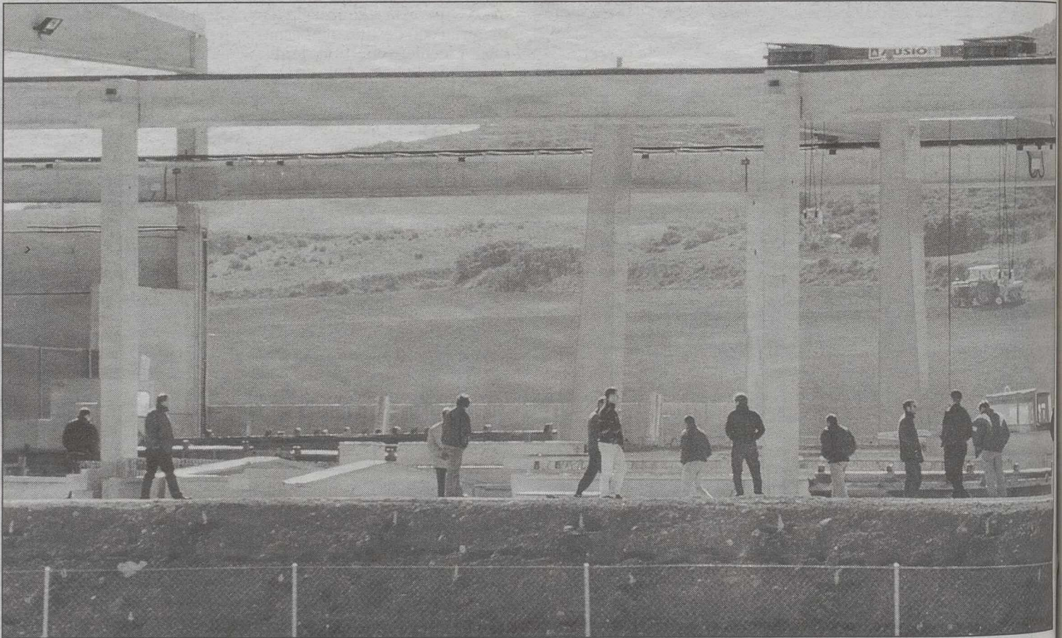
Dos jóvenes trabajadores de una fábrica de vigas en Almansa perdieron la vida en un accidente laboral.
