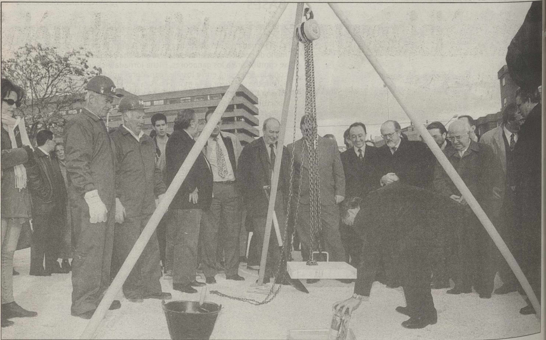
Apuesta decidida por la consolidación de la Facultad de Medicina cuyas obras ya han comenzado.
