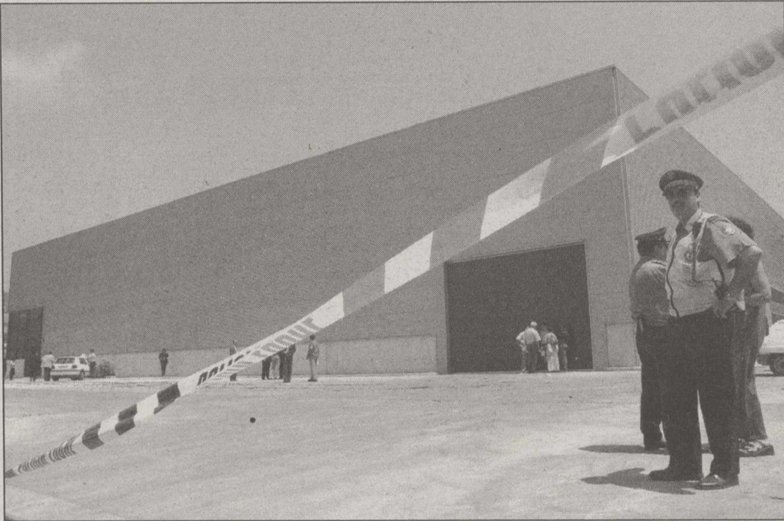
Planta de compostaje de lodos de Teia, donde ocurrió el accidente.
