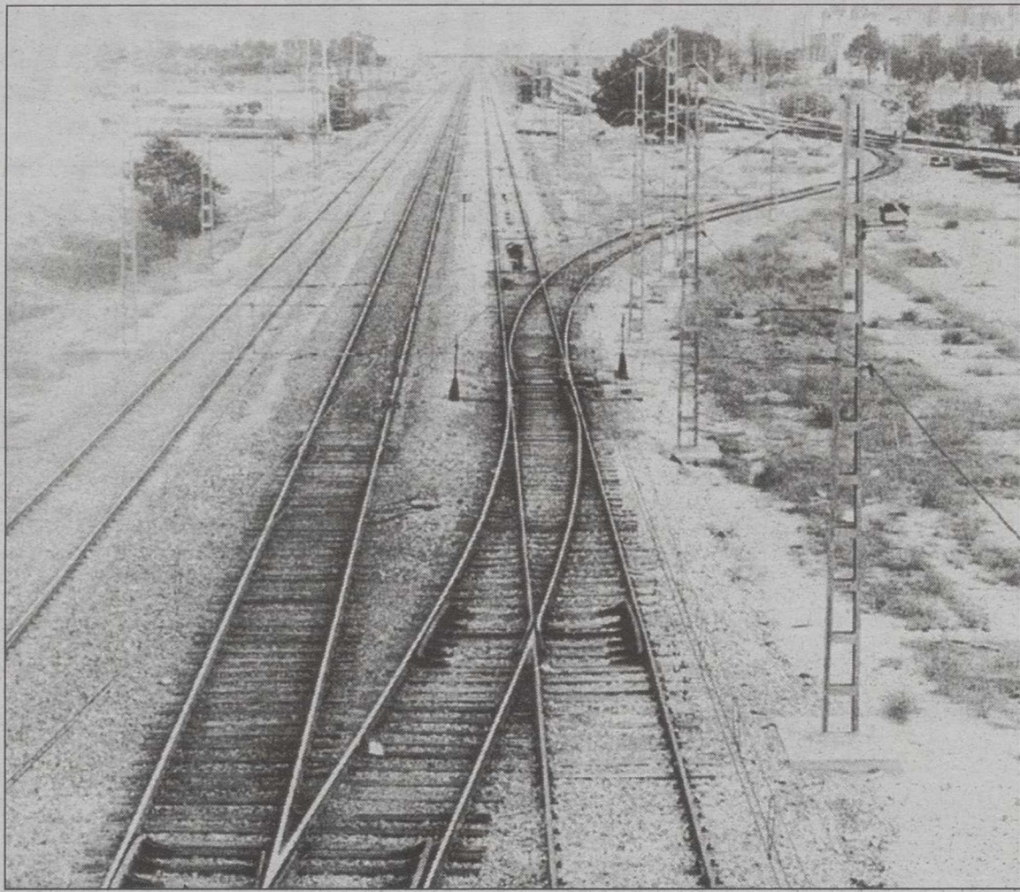
En los presupuestos del GIF para el 2000 hay dinero para el comienzo de las obras, según Valencia.
