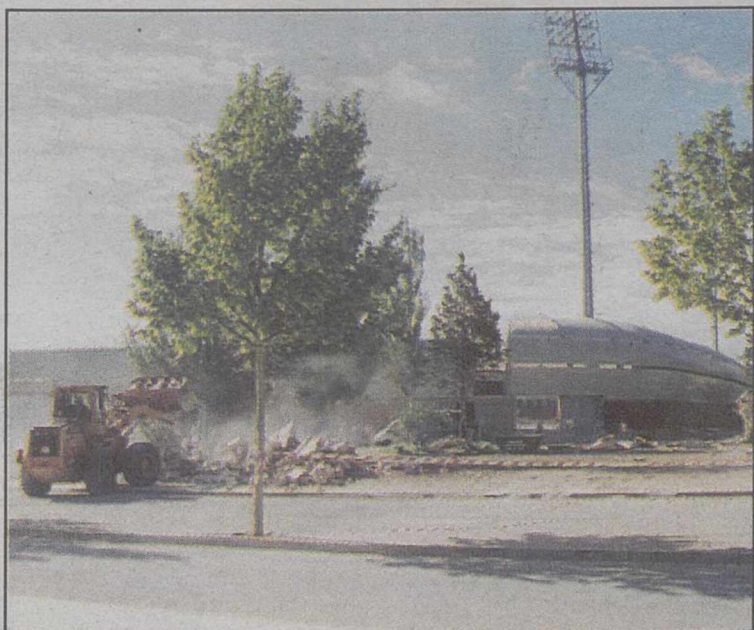
Comenzó el derribo de la histórica muralla del Carlos Belmonte.
