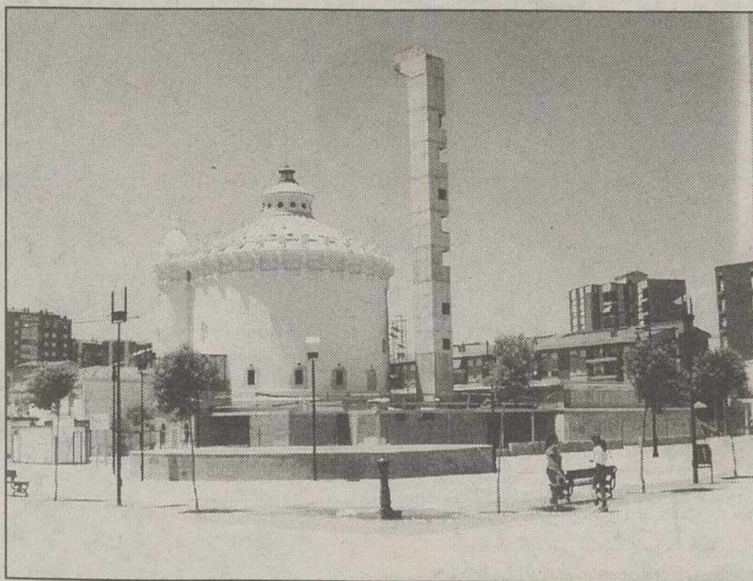
Las primeras obras se realizarán en cinco calles y una plaza de la capital.
