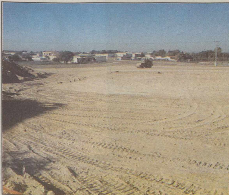
Primeros movimientos en las obras de las nuevas pistas.
