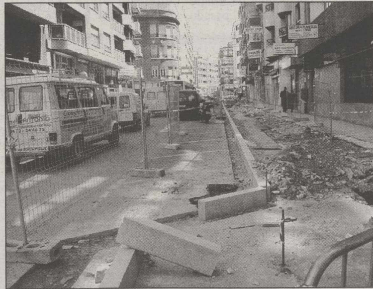
Obras de mejora del acerado en la calle San Agustín.
