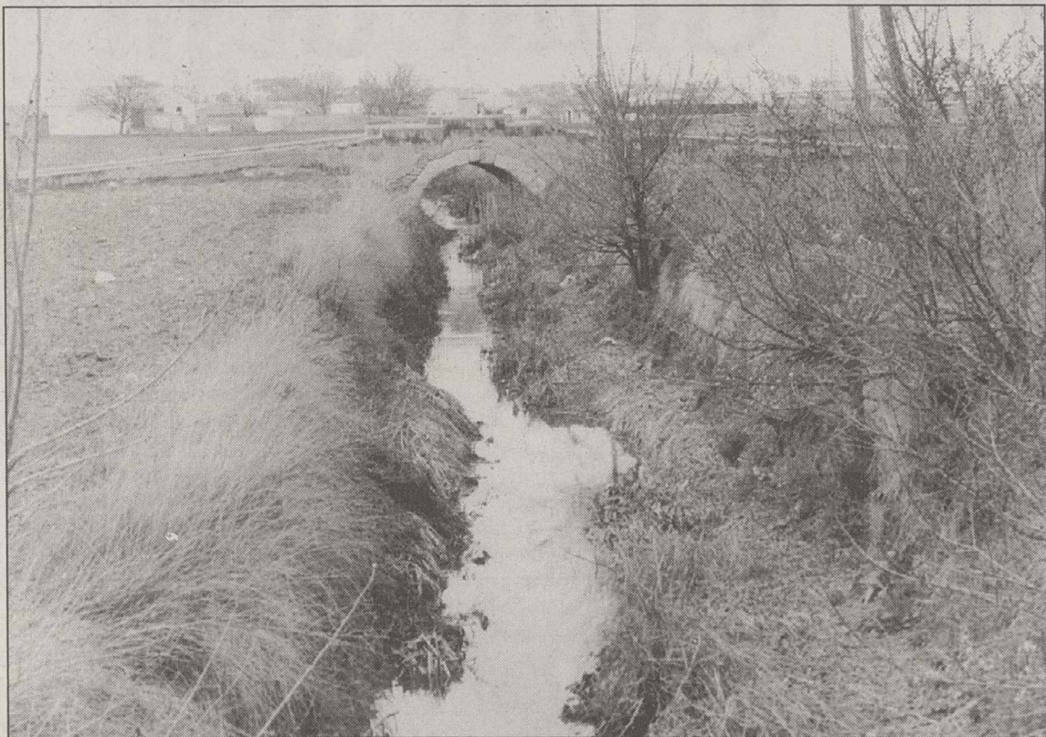
El proyecto de concentración parcelaria afecta a 2.000 hectáreas, de las 2.500 que tiene el término municipal.
