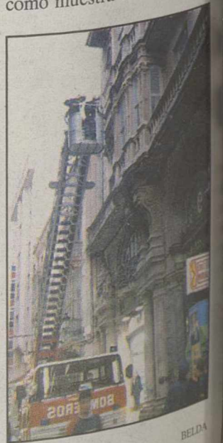
¿Peligro en el Pasaje?
