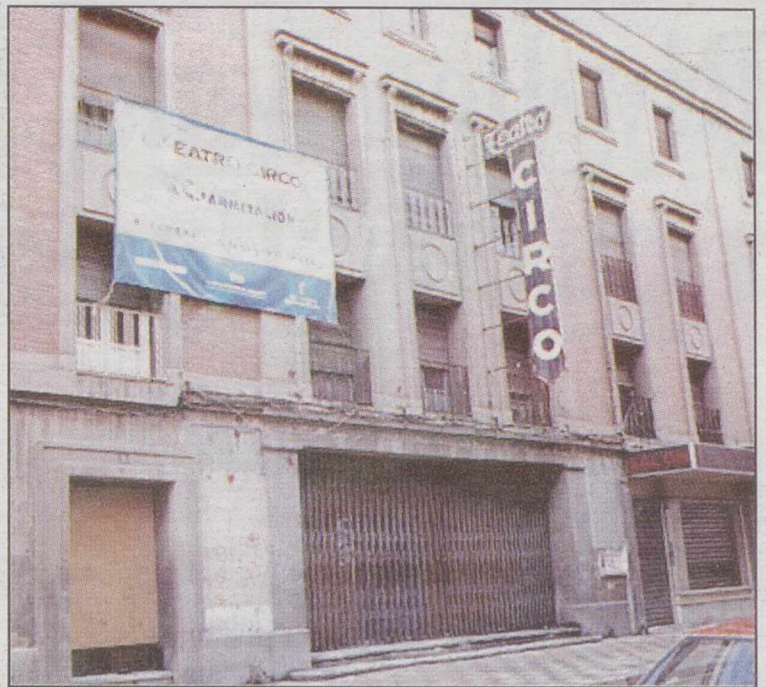
Fomento prevé que las obras del Teatro Circo comiencen antes del verano.
