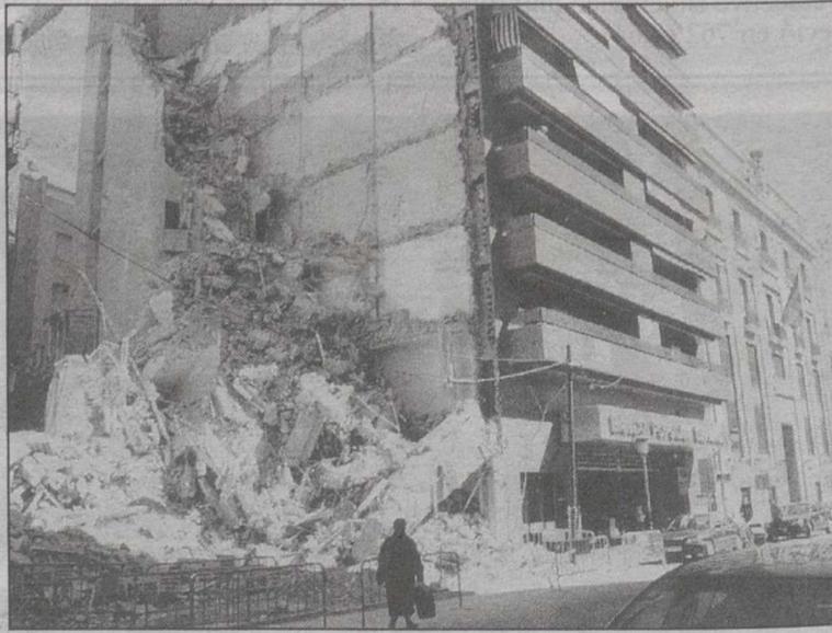
Las máquinas reiniciaron ayer la demolición del edificio de Martínez Villena.
