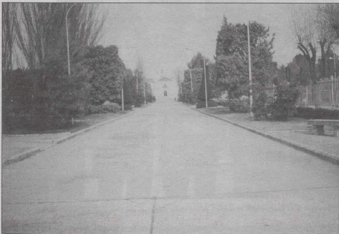
La semana pasada comenzaron las obras de remodelación del paseo de la Virgen.
