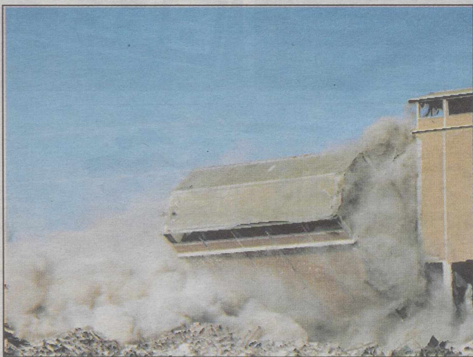
El derribo no causó ningún problema ni desperfecto en los alrededores.
