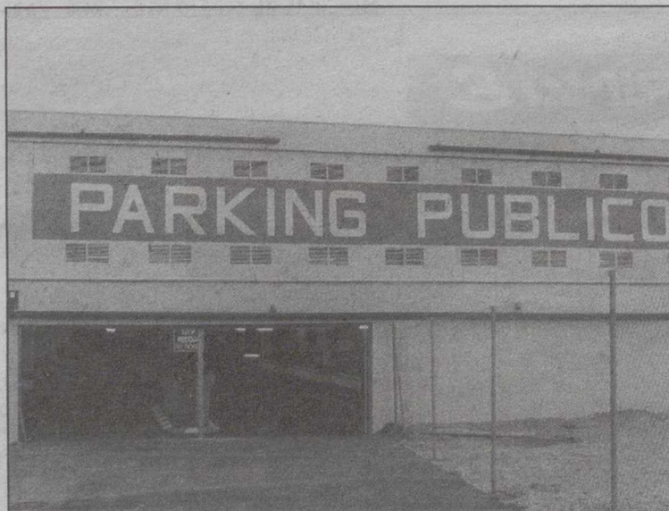
La mayoría de los aparcamientos inspeccionados no disponen de vigilante.
