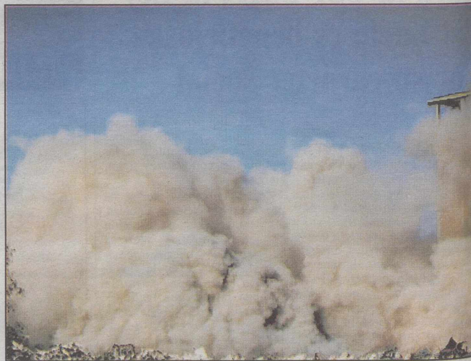
Una nube de polvo quedó en el lugar que ocupaban antes los silos.
