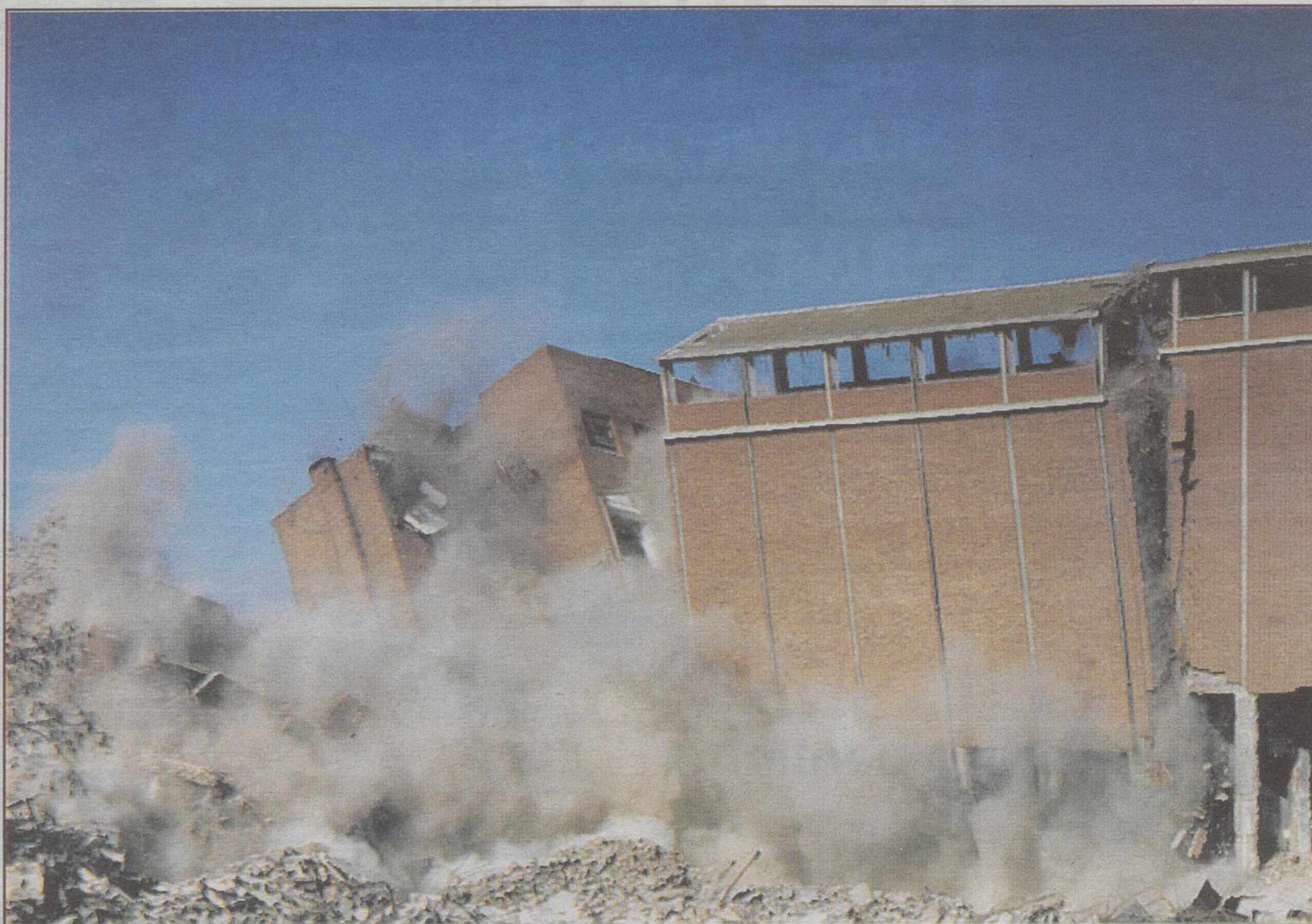
Los dos edificios cayeron gracias a las cargas de goma-2 colocadas de forma estratégica.
