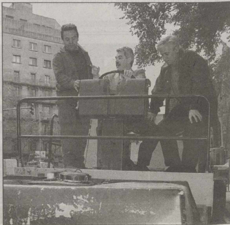
Pasqual Maragall visitó algunas obras de pavimentación.
