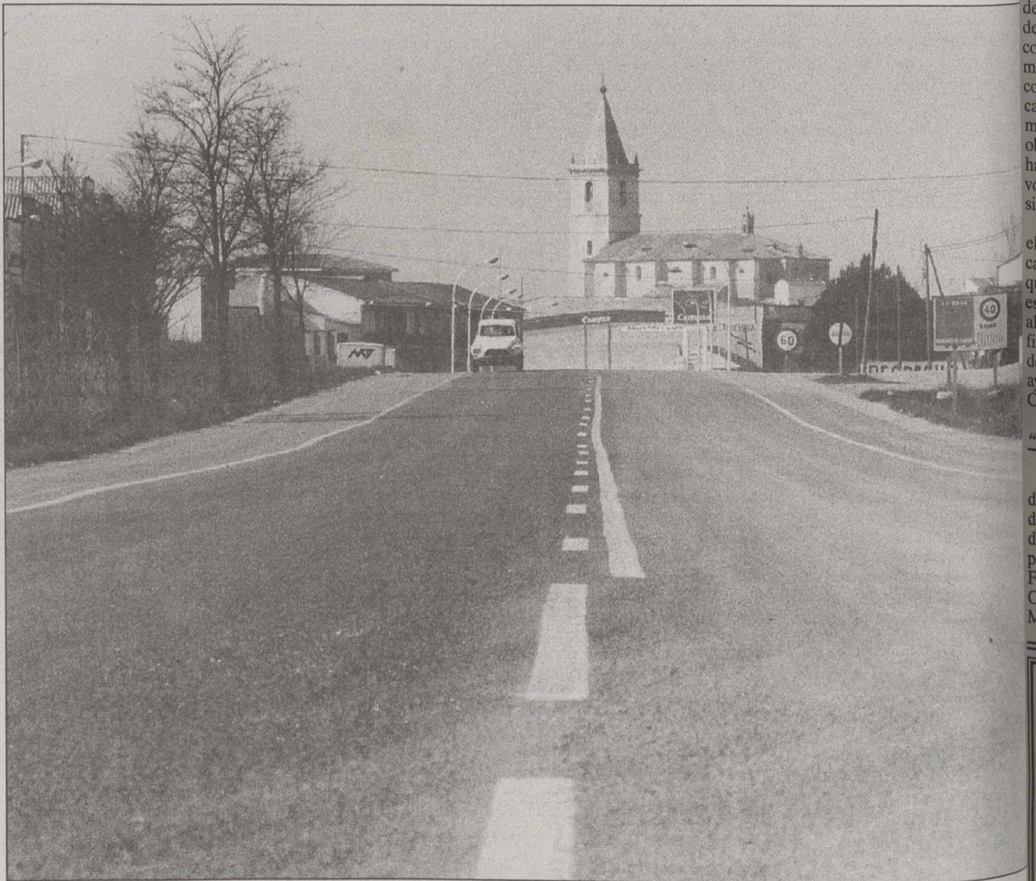
Las mejoras se centrarán en la reposición del asfaltado, construcción de nuevas aceras, implantación de aparcamientos y dotación de zonas verdes.
