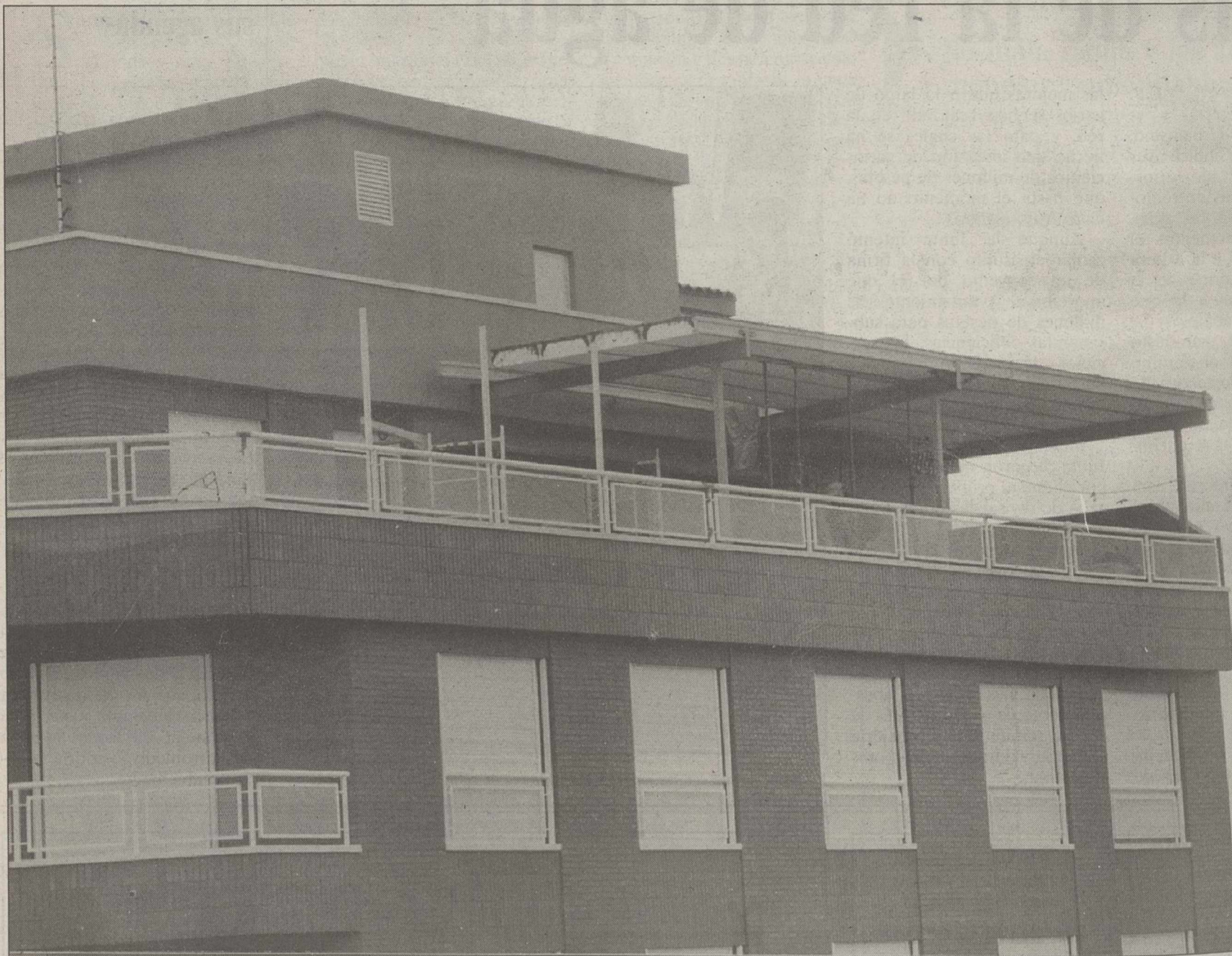
Un aspecto de las obras de cubrimiento de la terraza del concejal Antonio Tomás, que según los vecinos viola la normativa urbanística.
