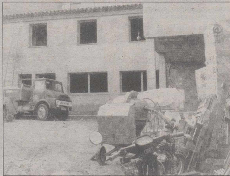
Las obras menores muchas veces consisten en nuevas plantas.
