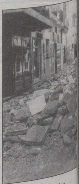
Las obras de nunca acabar.
