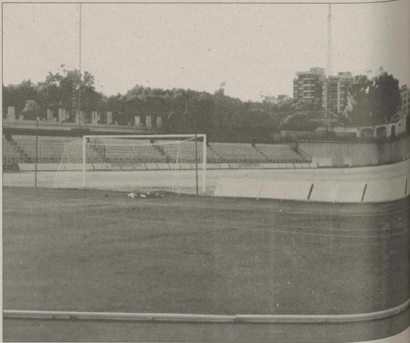
La piscina cubierta se ubicará junto al complejo polideportivo de Santa Ana.
