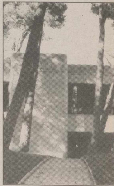
El Museo, de obras.
