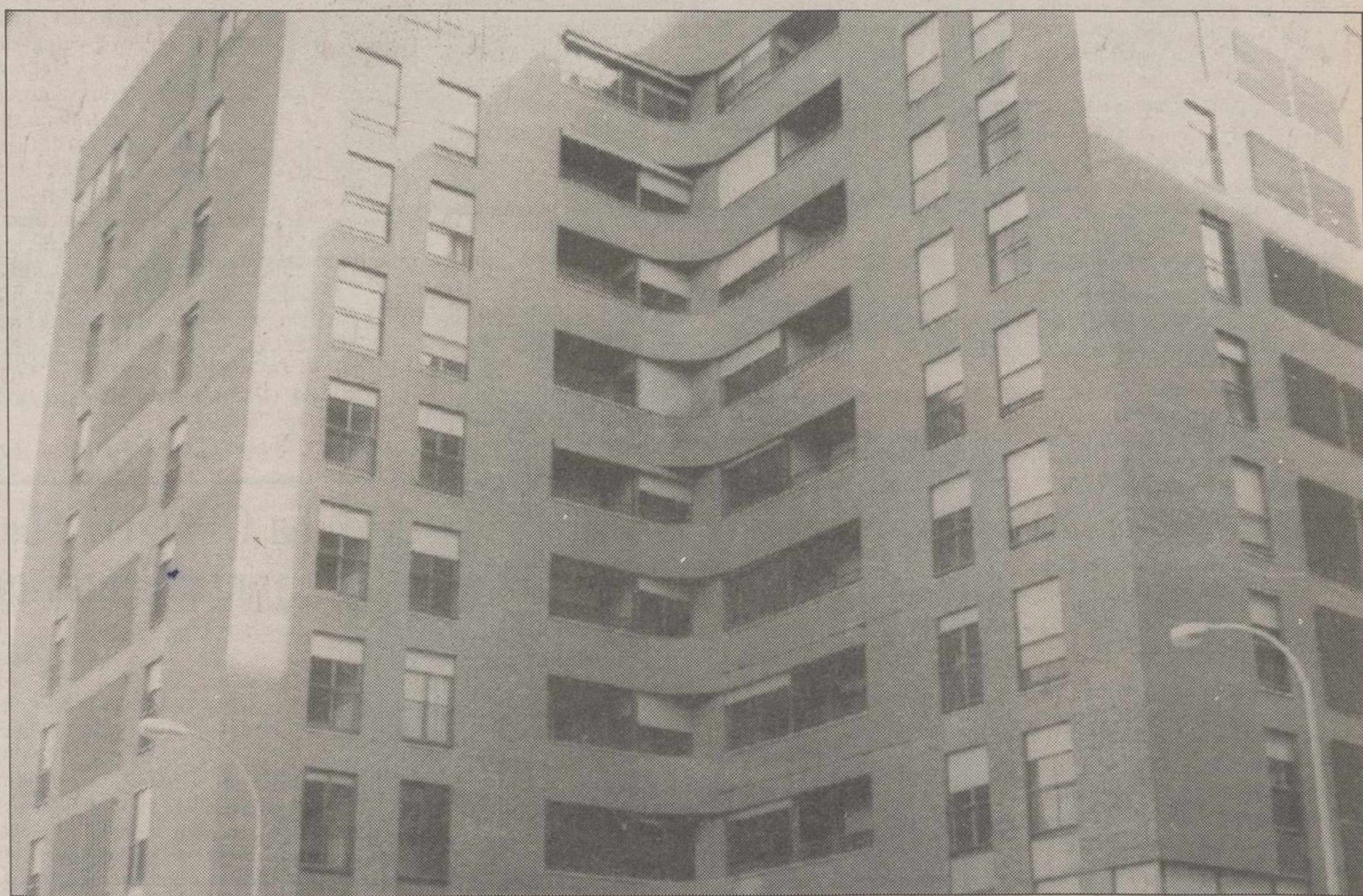
El Edificio Chinchilla se encuentra deshabitado desde hace dos años por requerimiento judicial.
