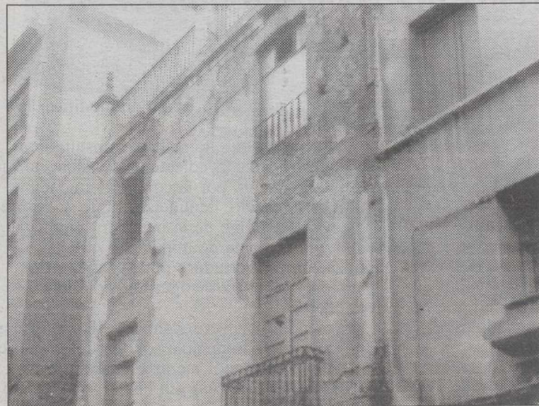
El Ayuntamiento procederá a la demolición de un edificio en ruina.
