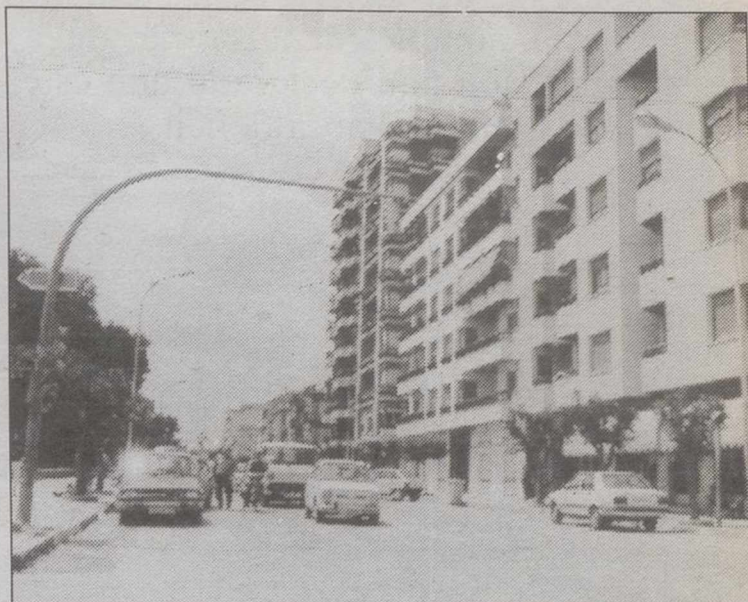
Malos olores en el alcantarillado de la Gran Vía.
