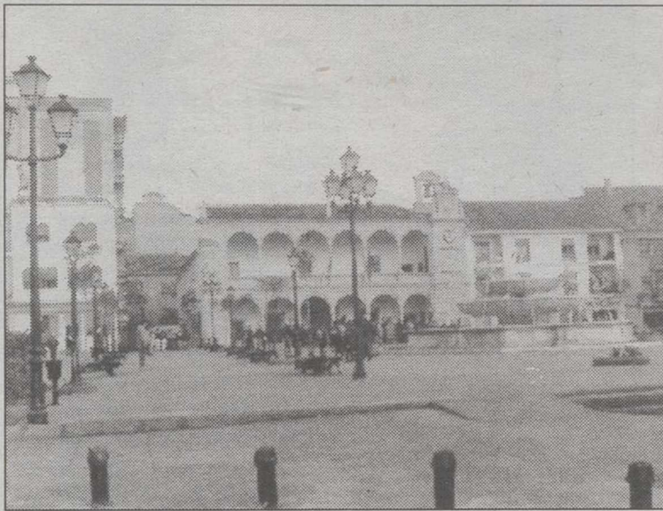
Adelanto en las obras del Ayuntamiento.
