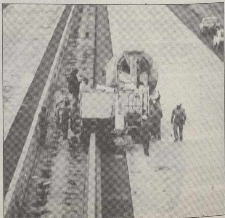
Los trabajos de construcción durarán aproximadamente un año.
