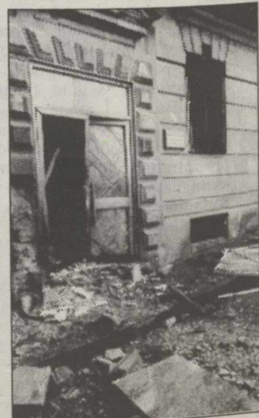
La fachada de la Comandancia.
