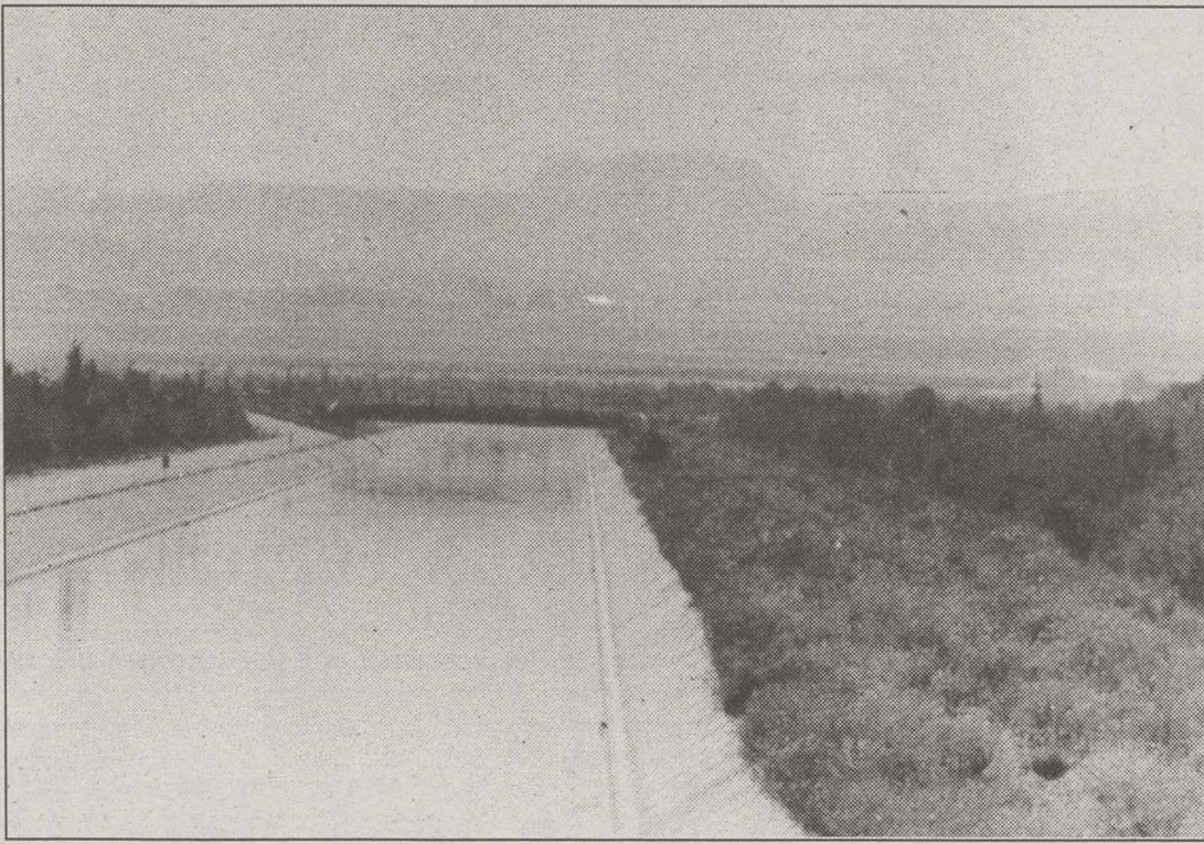
El Trasvase Tajo-Segura serviría para la recarga de las Lagunas de Ruidera desde Barrax.
