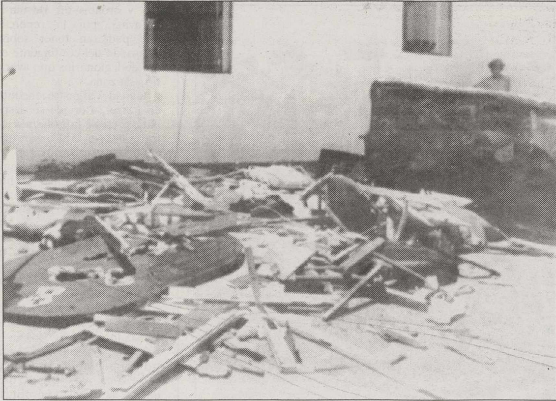
Una imagen de los destrozos causados por los payos en el pueblo de Mancha Real.
