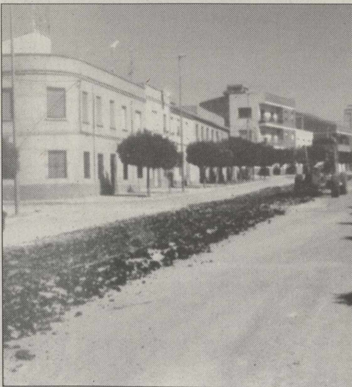
Continúan los problemas por las obras en la Avenida de la Constitución.
