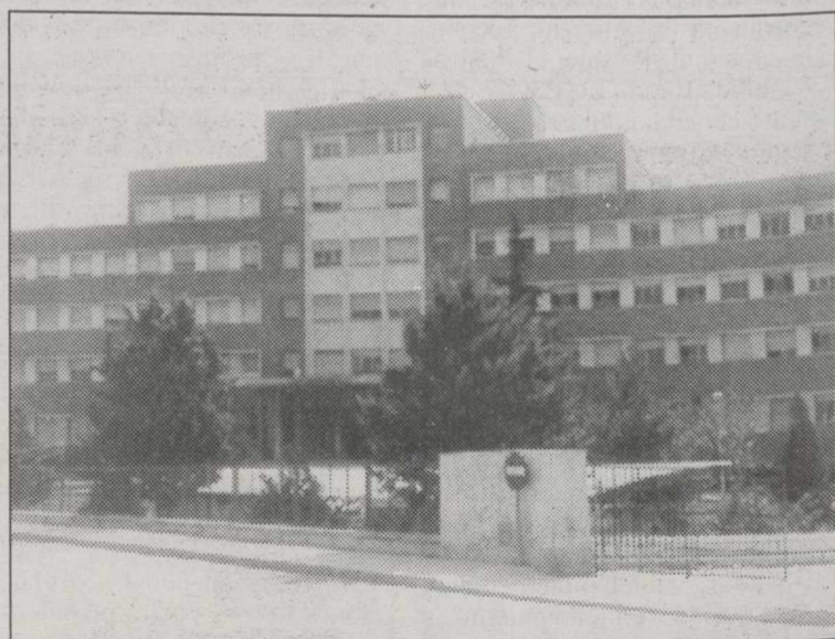
Antigua Residencia Sanitaria de Albacete.
