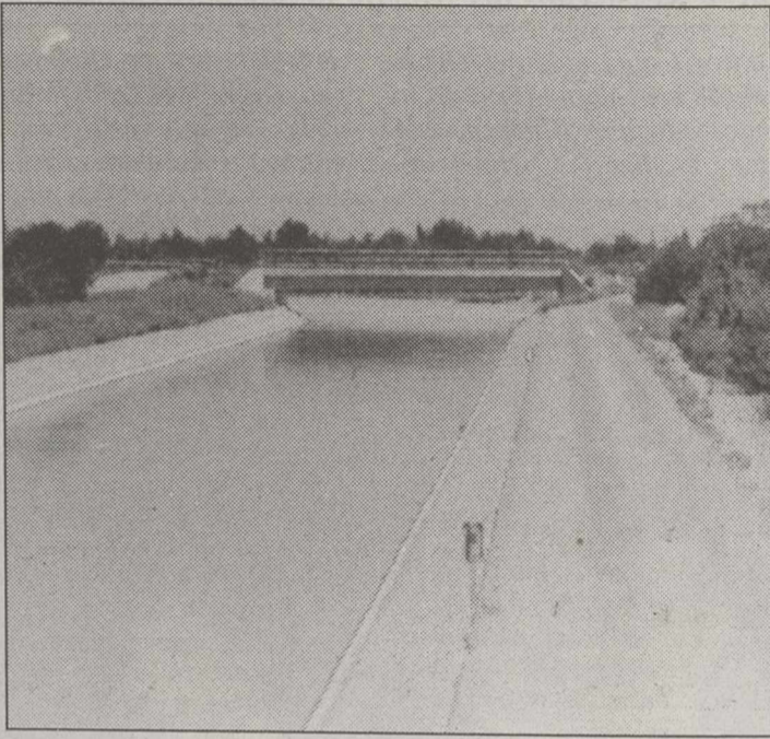
Fotografía del Acueducto Tajo-Segura.
