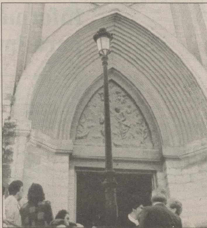
La arquivolta de la puerta principal, también en la restauración que plantea Peiró.
