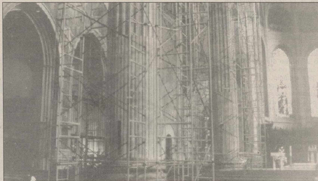
Preparación de la nueva iluminación interior de la Catedral.
