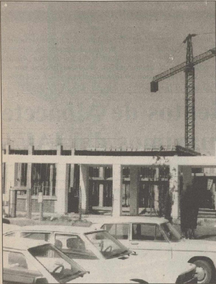
El edificio de Servicios Generales estará terminado a finales de este año. L.M.
