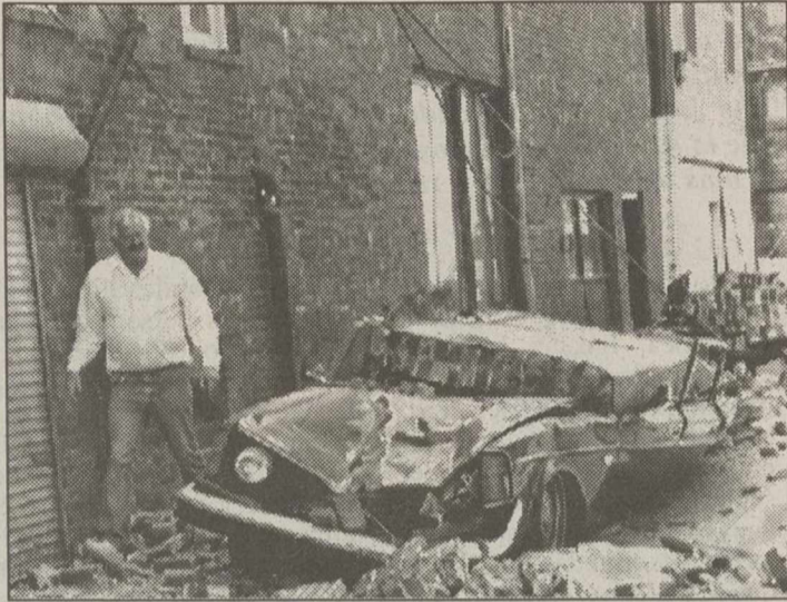
El fuerte temblor causó grandes destrozos.
